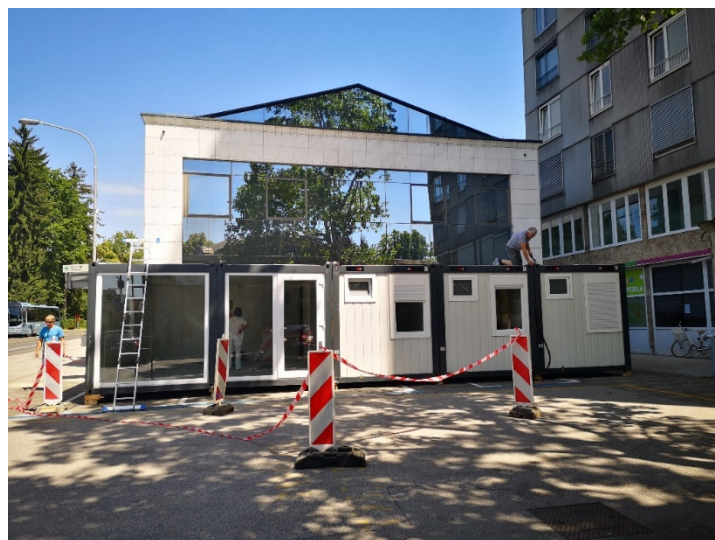
Slika 3: Nameščanje kontejnerjev začasno lekarno
